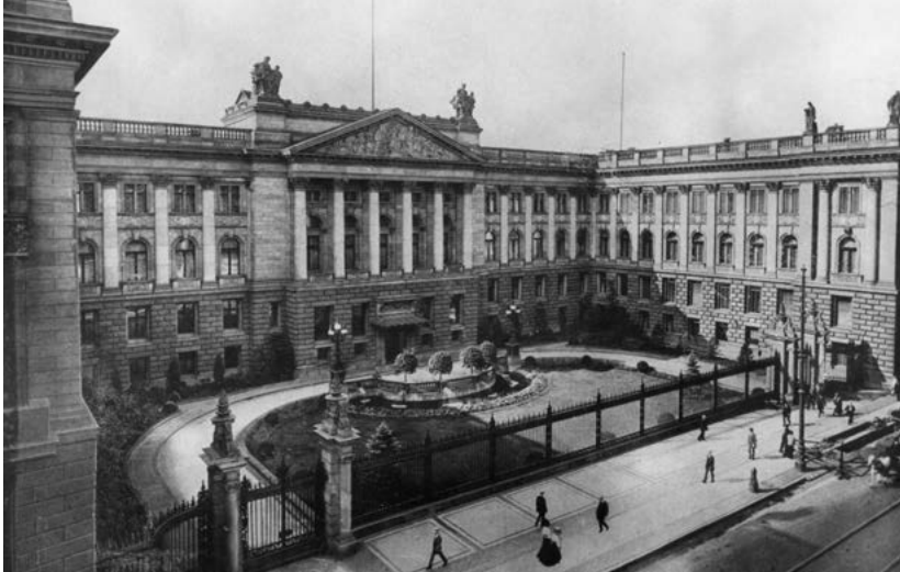
Architekt Friedrich Schulze-Colbitz entwarf das Herrenhausgebäude im Stil der italienischen Hochrenaissance. (Bildinfo: Genscher)
