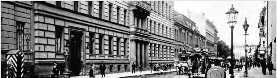
Blick auf das Gebäude Leipziger Straße 4, Ende 19. Jahrhundert
