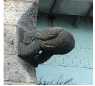
Das „Bröckemännche“ an der Bonner Rheinbrücke
