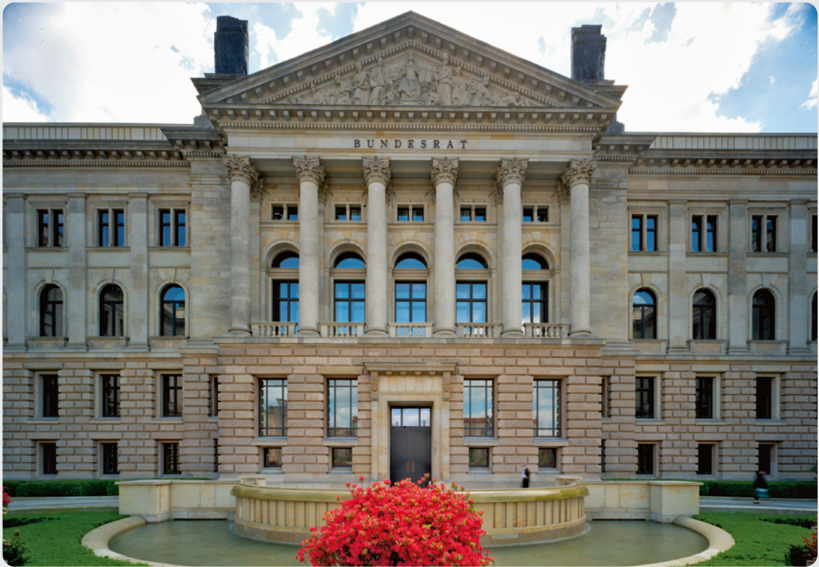
Das Bundesratsgebäude, Leipziger Str. 3-4
